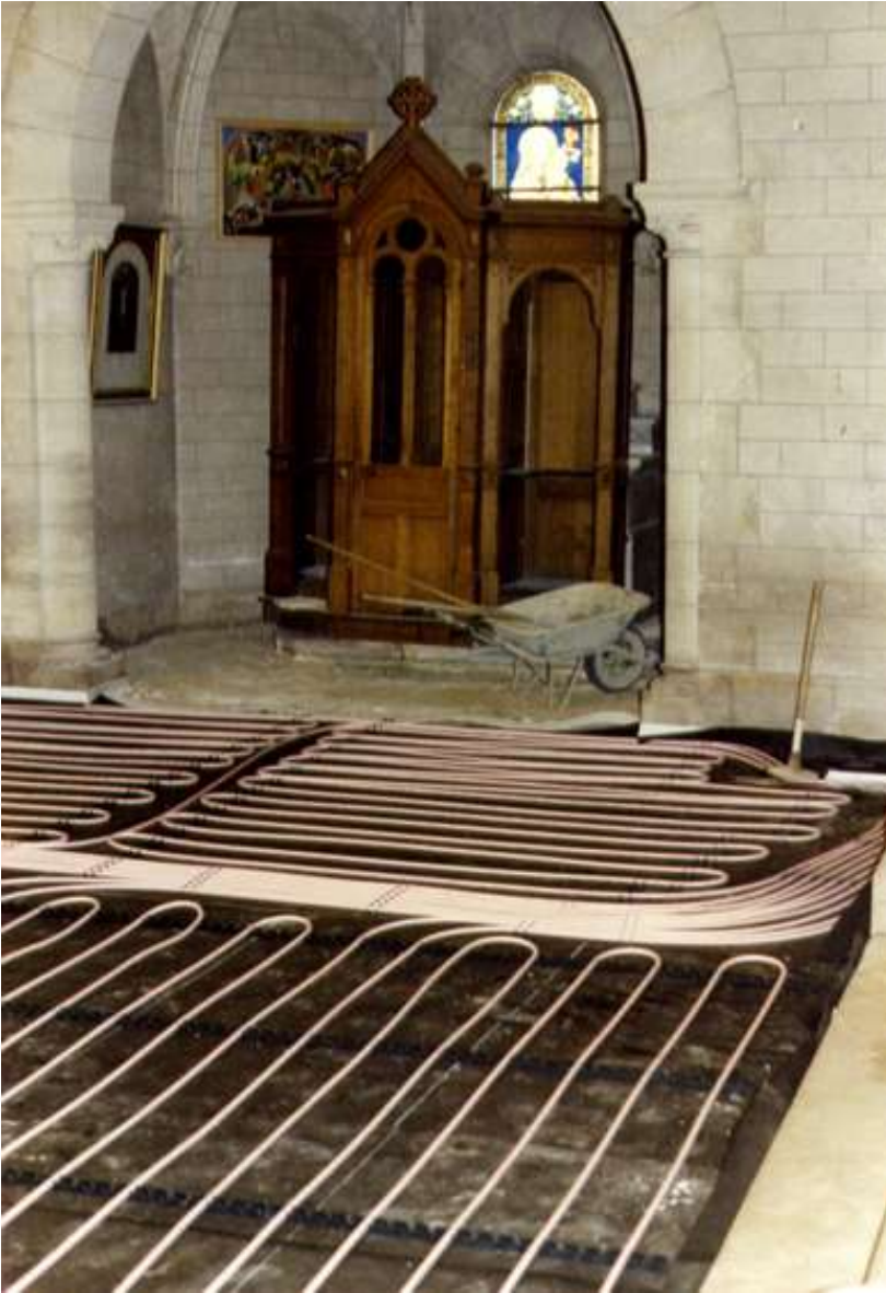
Installation du chauffage par le sol
