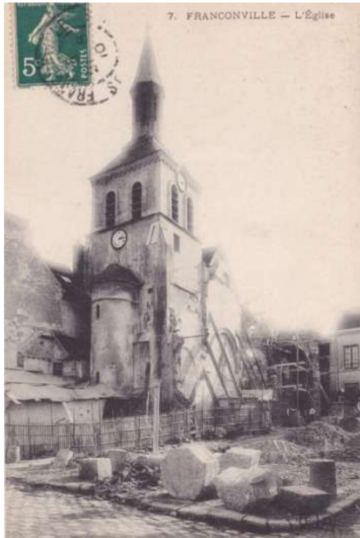
Ce qui reste de l'ancienne église et au fond la construction de la nouvelle
